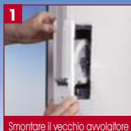
1 Smontare il vecchio avvolgitore
